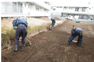
施工場所のスキ取りを行い、草木の除去、不陸整正を行い、下地の転圧を充分に行う。砕石路盤の場合、十分に締め固める。
