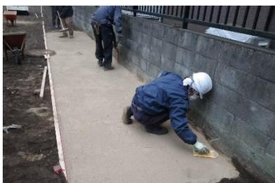
製品を必要な量だけ施工場所に配置します。用意した製品を施工場所に撒きます。コテなどで平滑に仕上げます。また厚さ確保のため、複数の個所で実際の厚さを測定してください。
