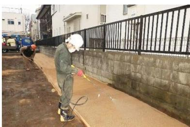
ジョウロや散水機で柔らかく均一に散水します。ロスが少ない現場でも、10リットル/m<sup>2</sup>以上、多い現場では10分おきに、2～3回に分けて20リットル/m<sup>2</sup>以上散水する。
