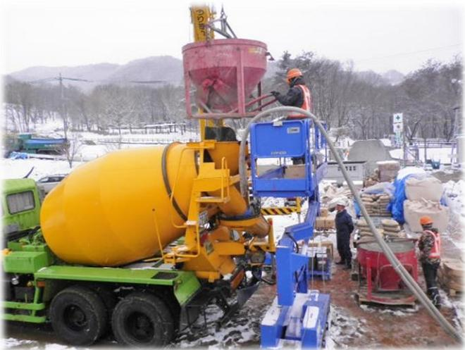
タフコートとは、山砂・真砂土・ダム砂・瓦チップ等の骨材に、硬化媒体であるセメント、当社開発の添加剤、IP-No.1PLUS(浸透硬化促進剤)、タフコート・ハイオール(専用安定剤)等を添加し、水を加える、現場で製造し打設する「土系舗装」です。
